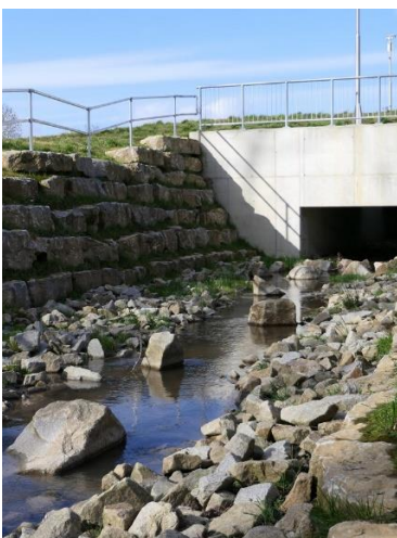
Ochsenbach Hochwasserrückhaltebecken in Richtung Norden. Foto: Bärbel Schlund, Schatthausen
